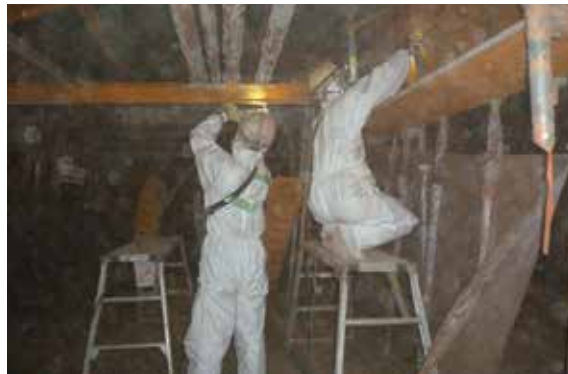
高速道路耐久性向上工事中鉛中毒災害
