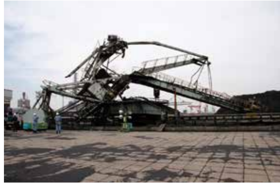
ジブローダーの折損災害
