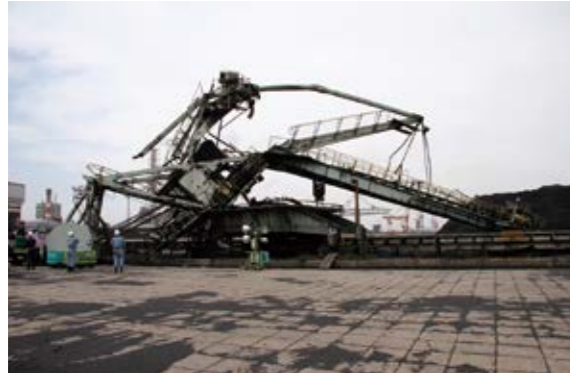
ジブローダーの折損災害
