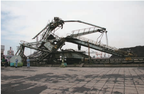
ジブローダーの折損災害
