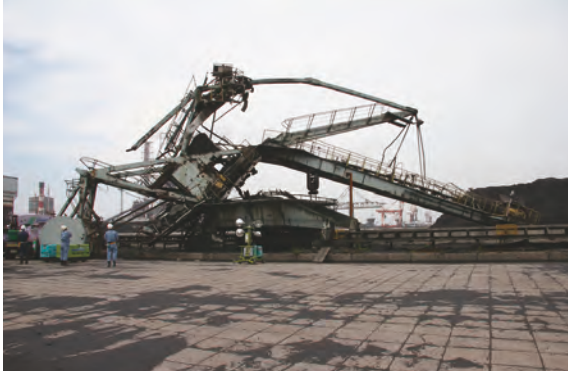
ジブローダーの折損災害
