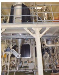
「粉体貯蔵槽における静電気危険性の研究」に使用する実規模実験装置
