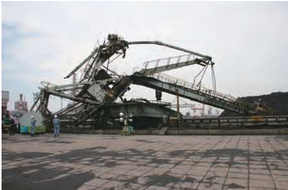
ジブローダーの折損災害
