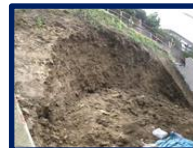
建設現場での土砂崩壊による災害
