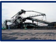
大型機械の折損による災害
