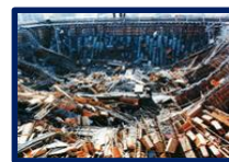
建設現場における仮設構造物の崩壊による災害
