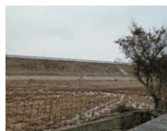
亶理町を南北に走る常磐自動車道
