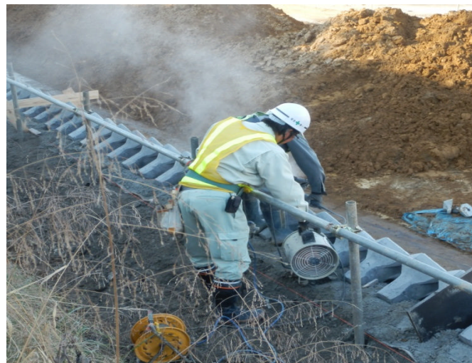
写真3 作業風景(ブローア使用時)
