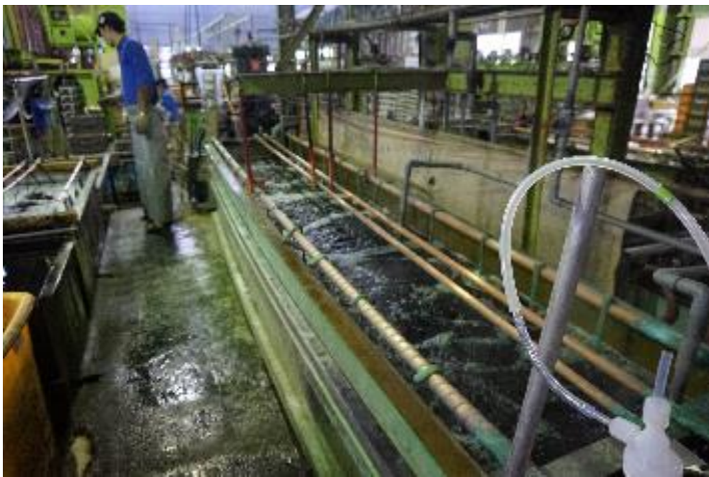
メッキ槽全景
