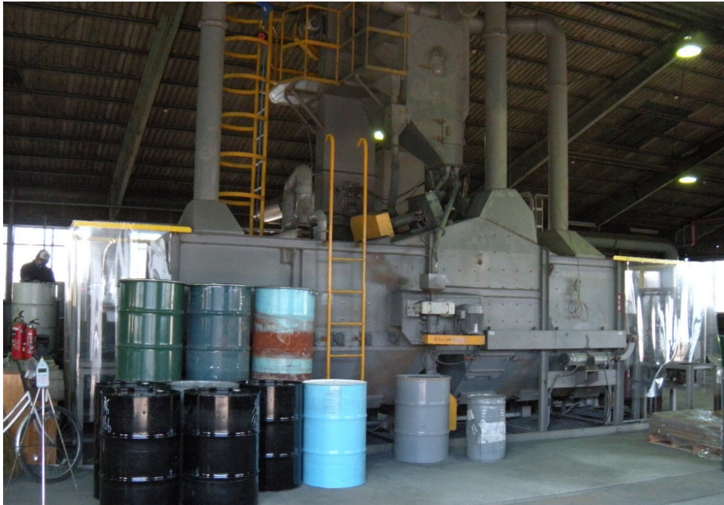
図3-2a：ショットブラスト出入口にビニール製カーテンを設けたところ、周囲の騒音が低減
