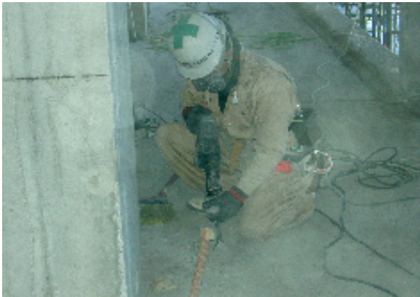
写真2 はつり作業風景
