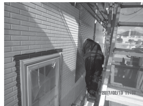
写真1 外壁塗装の現場及び作業風景
