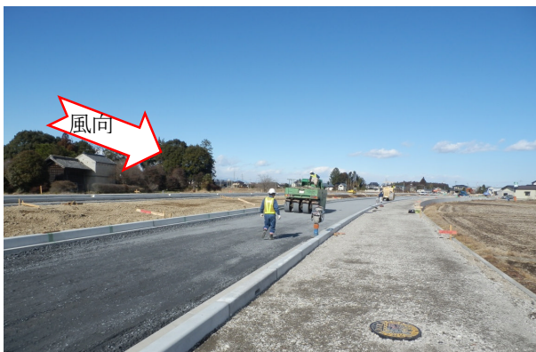
写真2 上層路盤の現場風景
