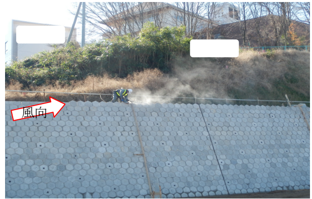
写真1 天端石切断の現場風景
