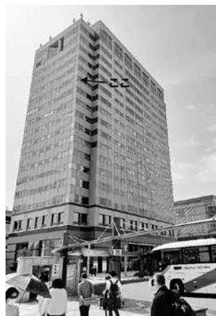
盛岡駅西口から見た当センターがあるマリオス（高さ92m）
