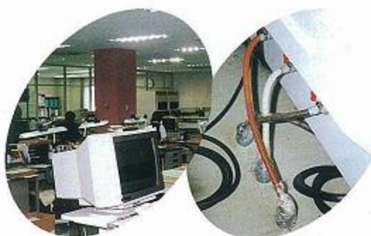
ディスプレイと天井の蛍光灯に反射防止措置が施されたVDT作業現場(向かって左)と、臭気漏れ防止措置が施された廃液ホース。安全衛生パトロールによる改善点だ。
