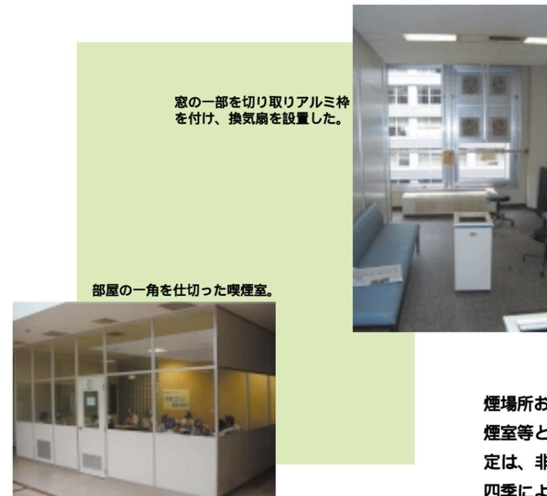
窓の一部を切り取りアルミ枠を付け、換気扇を設置した。
