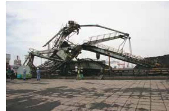
ジブローダーの折損災害
