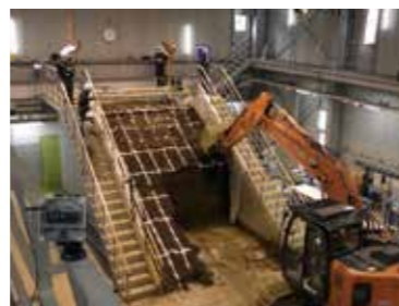
掘削工事における斜面崩壊の実大規模実験
