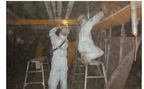
高速道路耐久性向上工事鉛中毒災害
